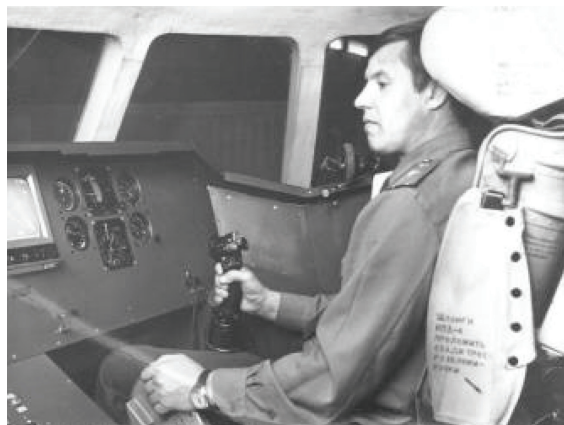
Рис. 12. Статическое рабочее место оператора стенда «Пилот-35» на базе макета кабины ОК «Буран» (в кабине тренажера специалист отдела М.Ф. Салмин)
