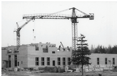
Рис. 1. Строящееся здание ЦФ-7 со стороны современной автостоянки № 7, 1969 г.
