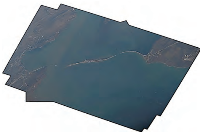
Рис. 6. Строящийся мост через Керченский пролив, 10.10.2017 г.
